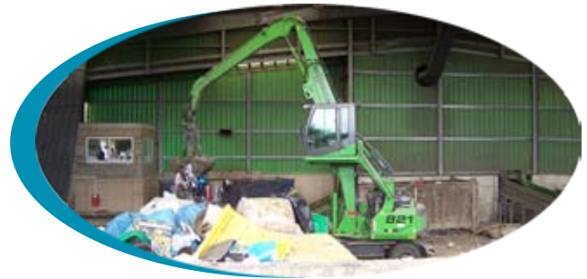
Der neue Radbagger für die MBA
